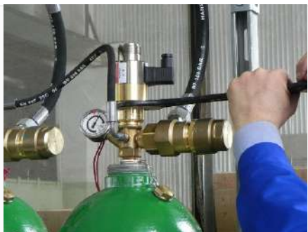
19. Установите электромагнитный привод на ЗПУ.
